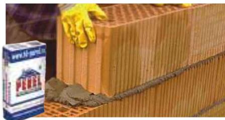
**TKS (теплая кладочная смесь)** - кладочная смесь с пониженным коэффициентом теплопроводности. Применяется в качестве раствора для кладки из поризованных керамических блоков и камней.
