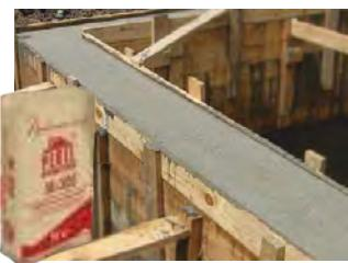
**M300** – Цементно-известковая смесь с добавлением полимерных добавок, применяется как мелкозерный бетон для заливки фундаментов, изготовления высокопрочных бетонных стяжек.
