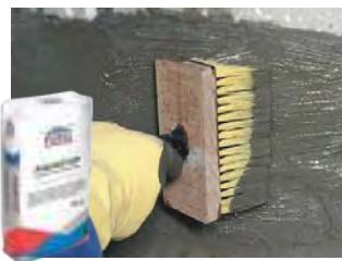
**Aquastop** – гидроизоляция обмазочного типа. Применяется для устранения водных протечек в помещениях с повышенной влажностью.
