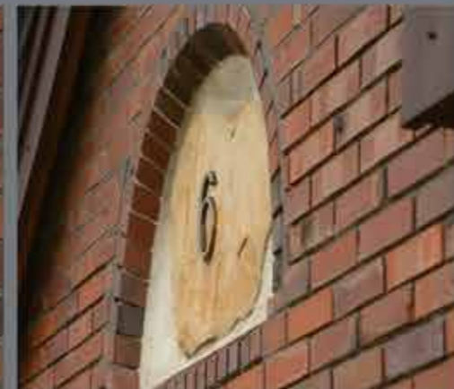
Gotika | Фасад здания | Томашув-Мазовецки
