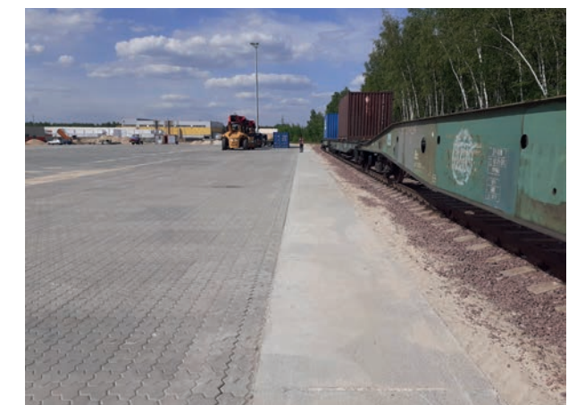
Рис.5. Вид покрытия вдоль ж/д путей
