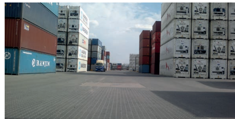
Рис. 2. Покрытие из камней мощения на площадке складирования контейнеров
