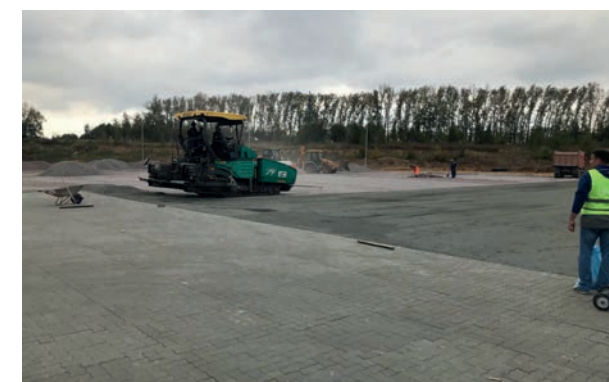
Рис. 4. Подготовка подстилающего слоя
