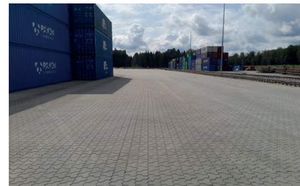
Рис. 2. Покрытие вдоль ж/д путей
