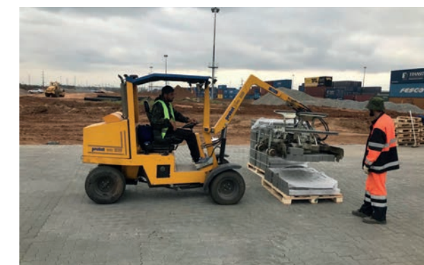
Рис. 5. Процесс укладки камней механизированным укладчиком «Probst»
