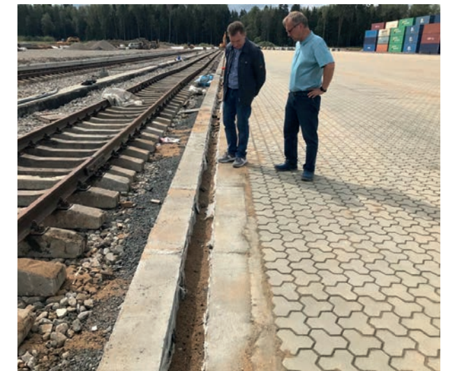
Рис. 3. Визуальный осмотр покрытия
