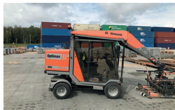
Рис. 5. Процесс укладки камней механизированным укладчиком «Optimas»
