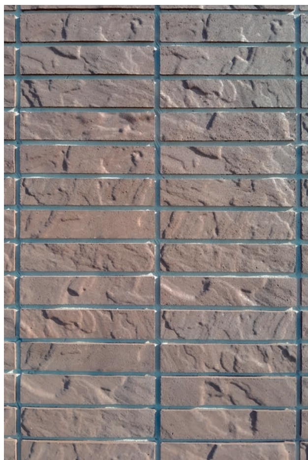
Фрагмент облицовки стены плиткой с рельефной поверхностью
