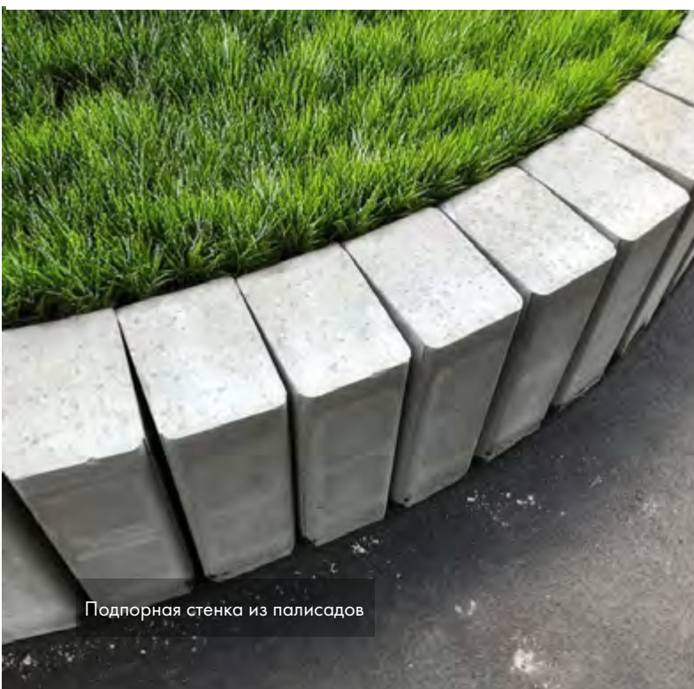
Подпорная стенка из блоков «Растефлор»
