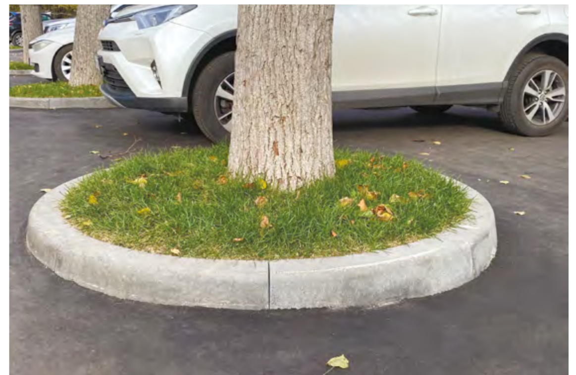
Приствольный круг из радиусных бортовых камней R = 1 м наружных
