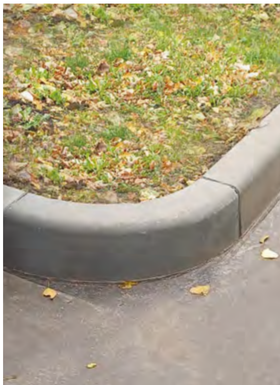
Закругления из бортового камня радиусного R=0,5 м наружного
