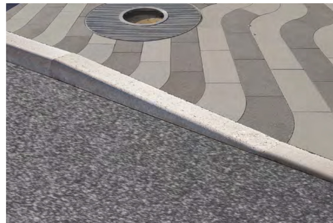
Левый бортовой камень для устройства понижений
