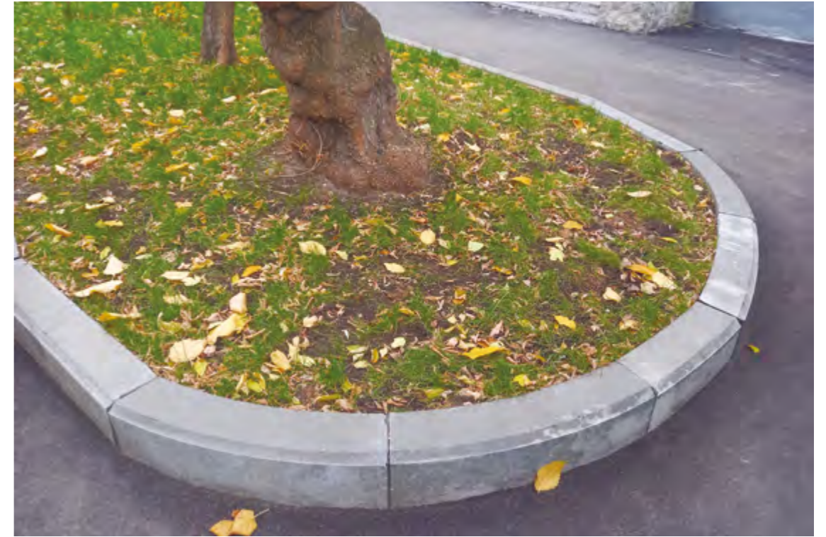
Закругления из бортовых камней радиусных с фаской наружных R=1 м
