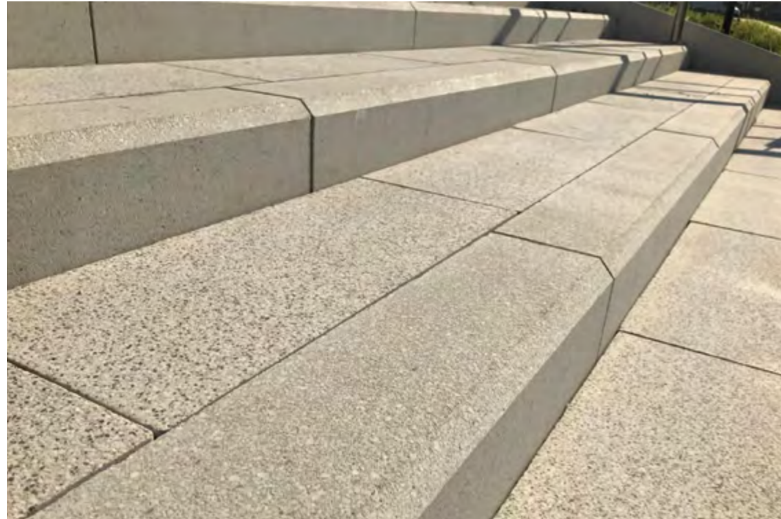
Бортовой камень композитогранитный БР 100.30.15 с фаской. Цвет: гранит белый
