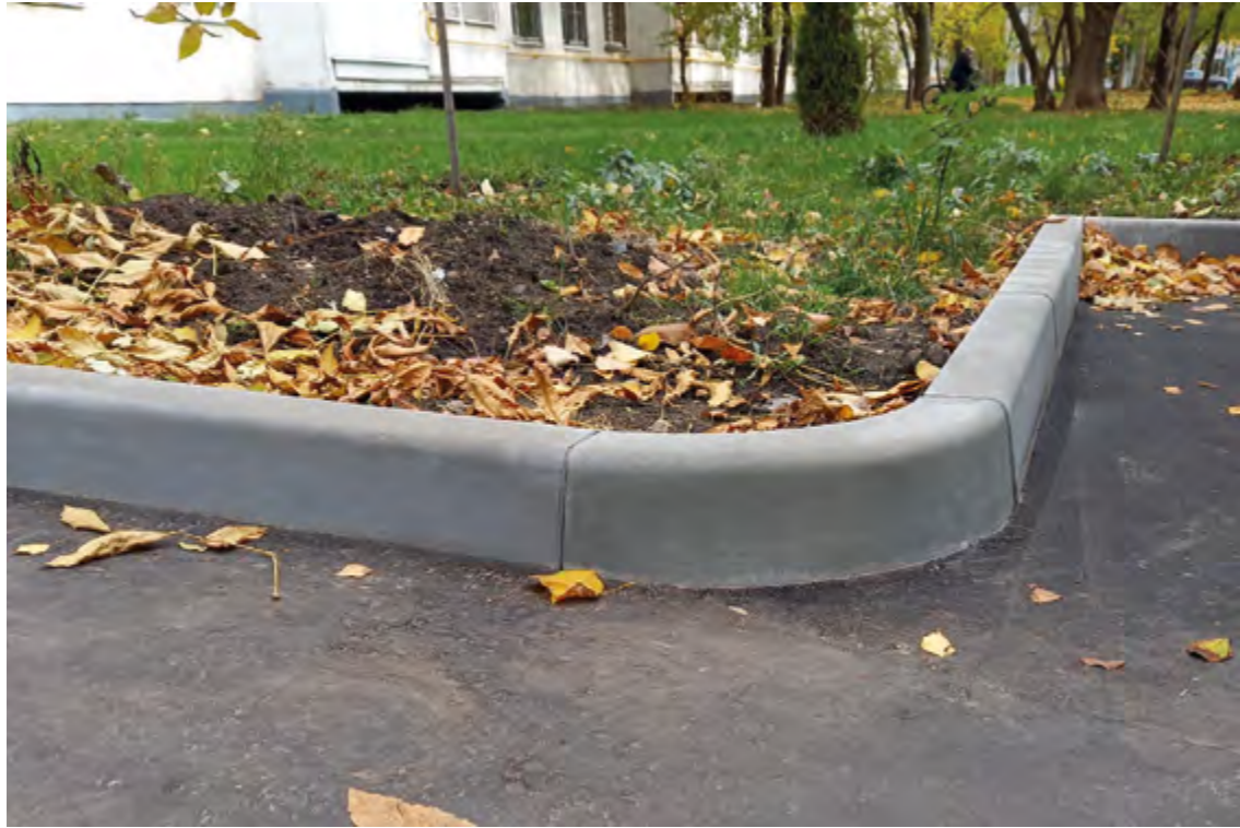
Закругление из бортового камня радиусного R = 0,5 м наружного
