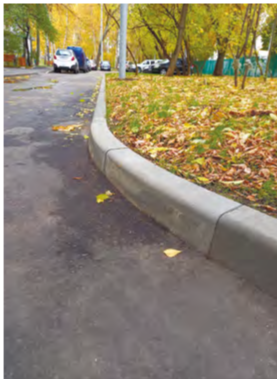
Закругление из бортовых камней радиусных наружных
