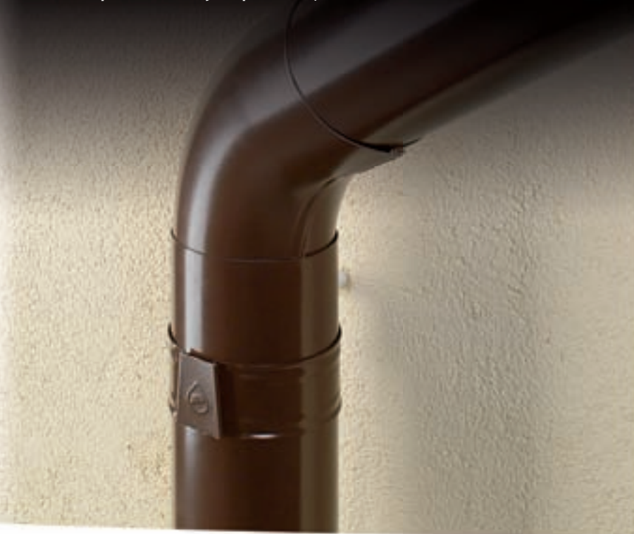
Крепление хомута при помощи клина
