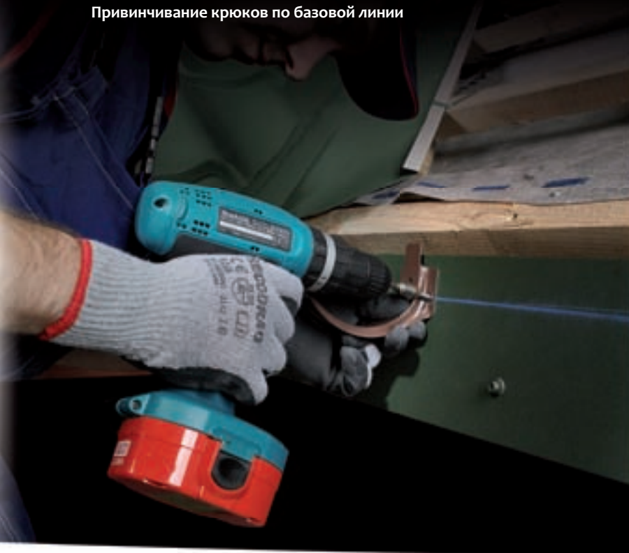
Привинчивание крюков по базовой линии
