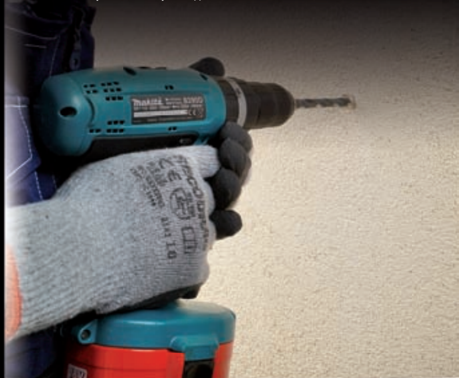
Сверление отверстия для болта
