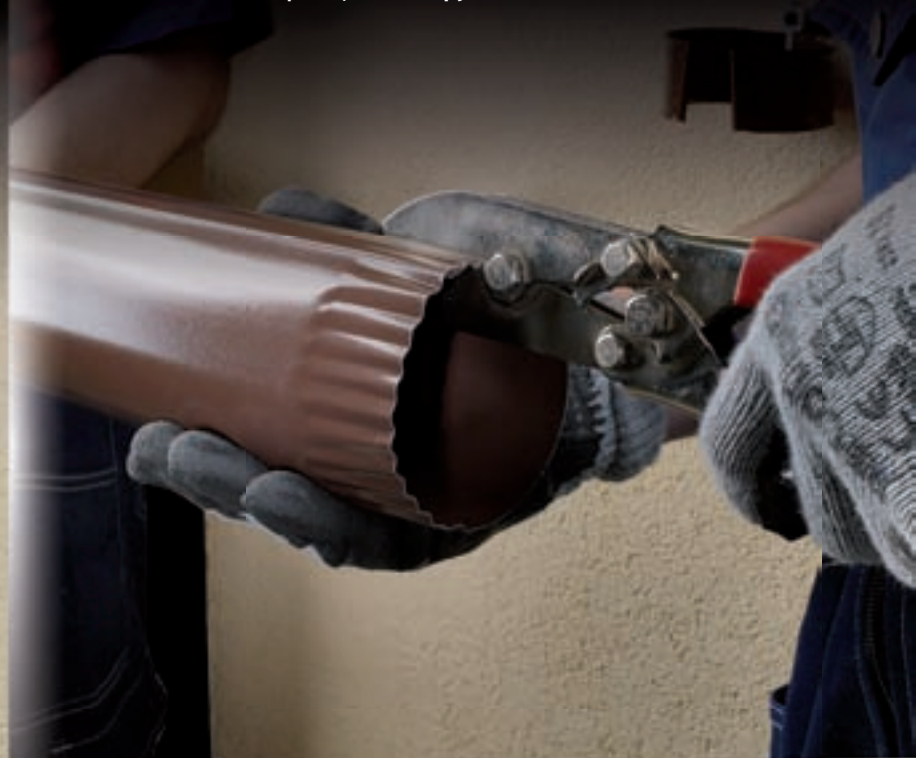
Выполнение фальцовки на трубе
