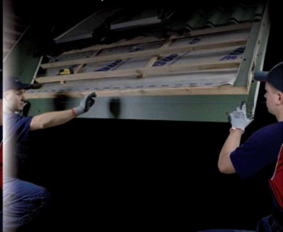
Разметка линии уклона
