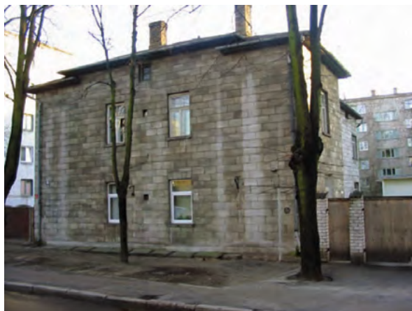
Рис. 1. Здание из автоклавного газобетона без наружной отделки. 1939 г.п., г. Рига, ул. Эльвирас, 15
