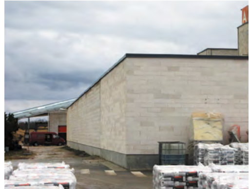
Рис. 4. Завод по производству автоклавного газобетона со стенами из неотделанной кладки, 2002 г.п., Эстония, волость Сымеру
