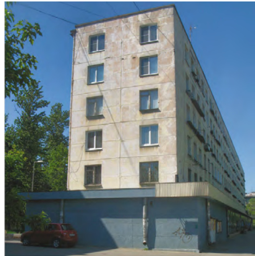
Здание из автоклавного газобетона, 1960-е гг. Санкт-Петербург, Краснопутиловская ул., 45
