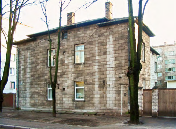
Здание из автоклавного газобетона без наружной отделки. 1939 г.п., г. Рига, ул. Эльвирас, 15
