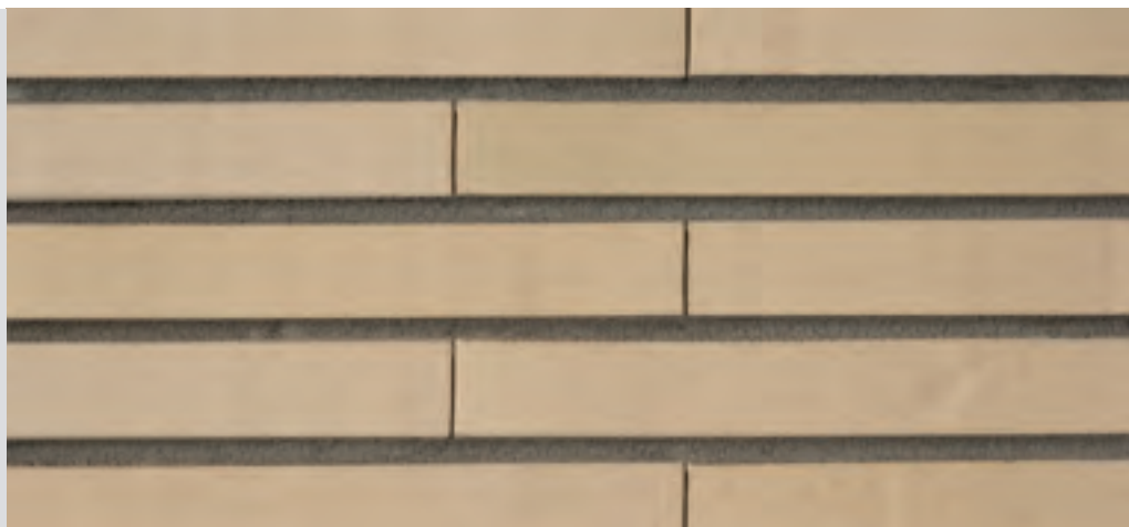
dunkle Lagerfuge im Kontrast, ohne Stoßfuge
