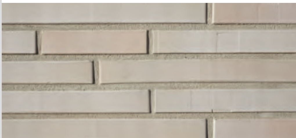
Klinker und Fuge im Farbbild angeglichen
