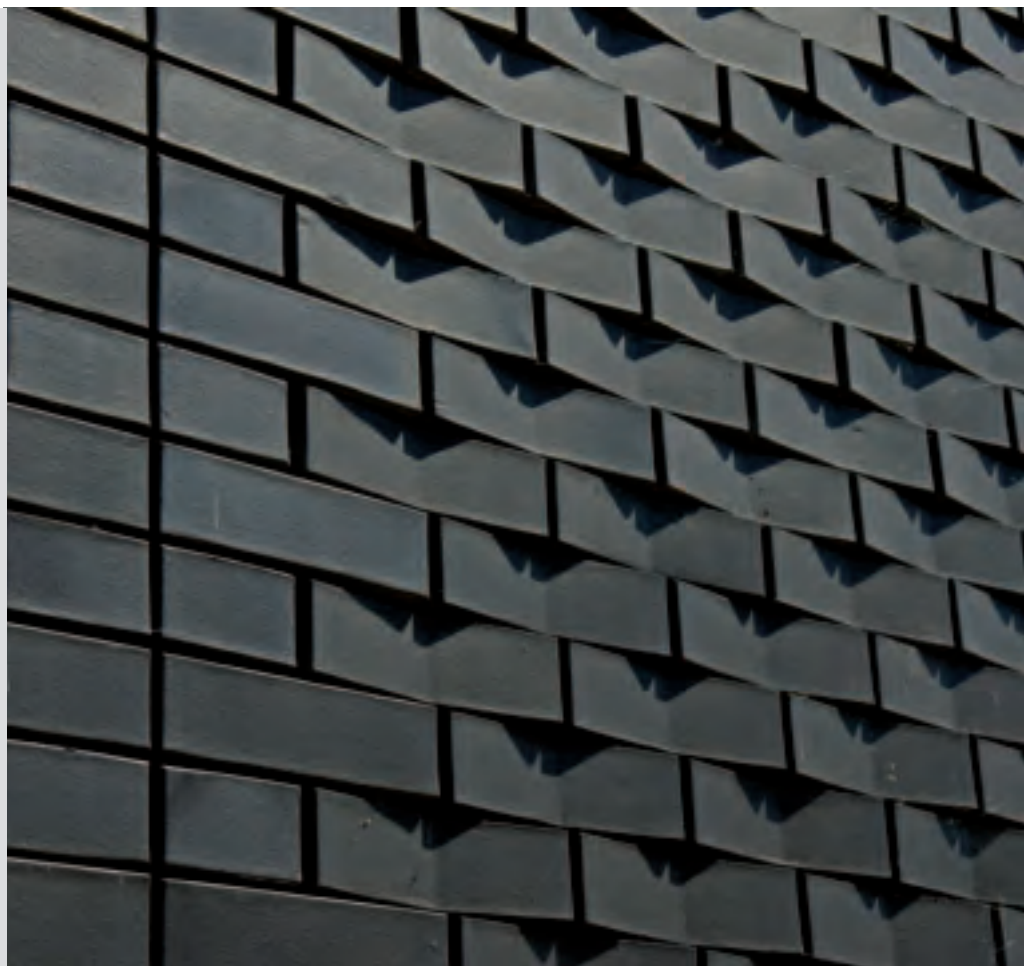
seitliche Ansicht: Sch5954 Dresden schwarz-blau-bunt glatt NF, Schattenfuge, ohne Mörtelfuge geklebt
