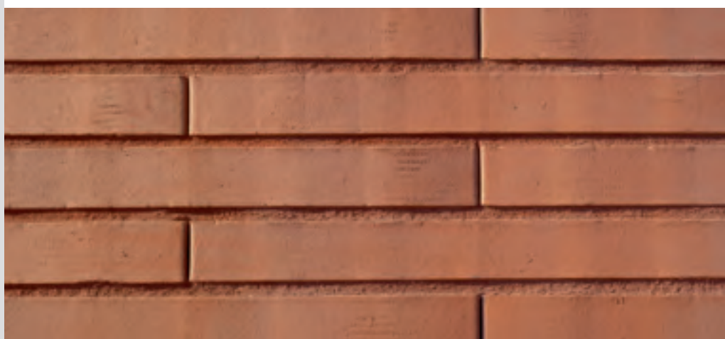
rote Lagerfuge, ohne Stoßfuge, Langformat
