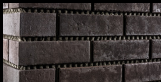
Полностью облицованная поверхность. После времени выдержки можно приступать к расшивке швов.
