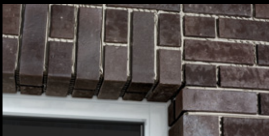
Оконный откос, превосходно выполненный с помощью углового элемента.
