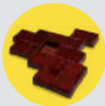
Расшатывание брусчатки и западание отдельных плит
