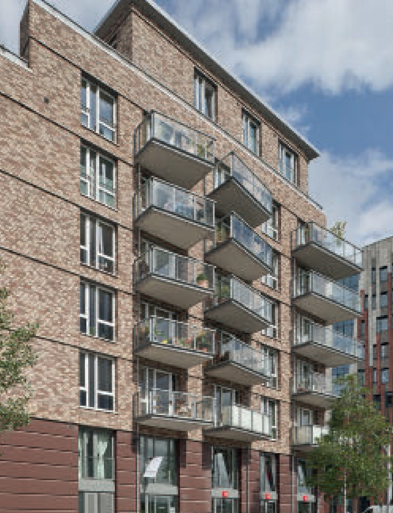
Плитка Feldhaus Klinker артикул R690NF14 серии Sintra в теплоизоляционной системе облицовки фасада с приклейкой плитки и затиркой швов.
