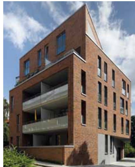
Жилой дом, Германия Плитка фасадная 7440/353 eisenrost Плитка угловая 7471/353 eisenrost
