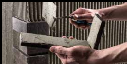
С уголками работают по методу двойного намазывания.
