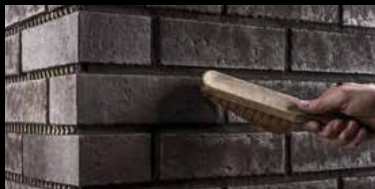
Обметание шва при помощи щетки придает ему соответствующую структуру.
