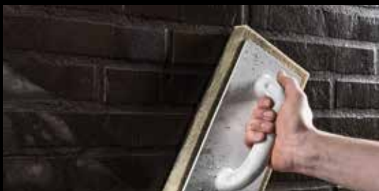
С помощью штукатурной рейки с губкой по диагонали смывают избыточный раствор.
