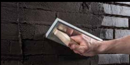
По методу поверхностной затирки швы заделываются с помощью расшивочной или штукатурной рейки. Настенные поверхности обрабатываются сверху вниз.
