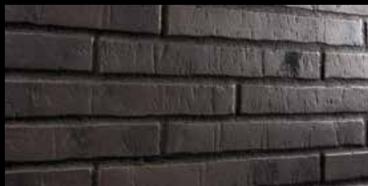
Готовый вид шва.
