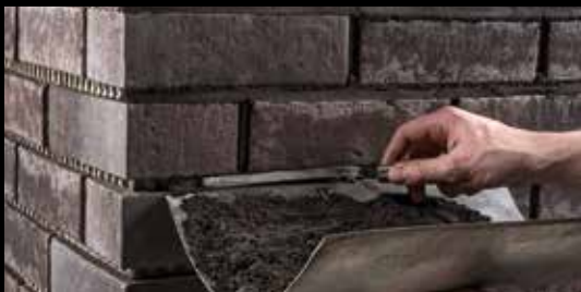
Расшивка с помощью мастерка для расшивки швов в горизонталях.
