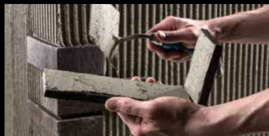
С уголками работают по методу двойного намазывания.
